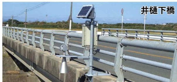
水面から堤防までの高さを確認できます。(平常時は1日1回のみ)
