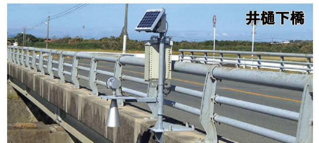
水面から堤防までの高さを確認できます。(平常時は1日1回のみ)
