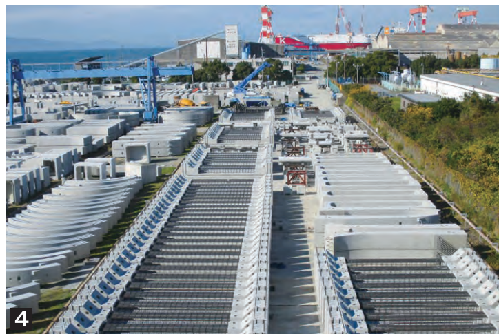
1 工場外観 2 地域未来牽引企業にも認定されました 3 トロリーから流し込まれた生コンクリートを、型枠に流し込んでいきます。 4 出荷を待つコンクリート製品
