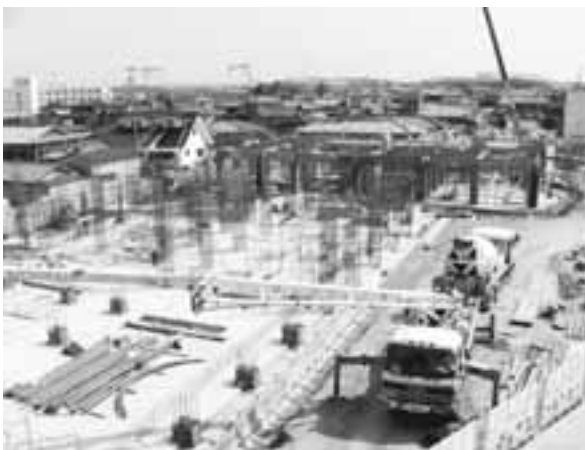
▲長洲小校舎改築工事
