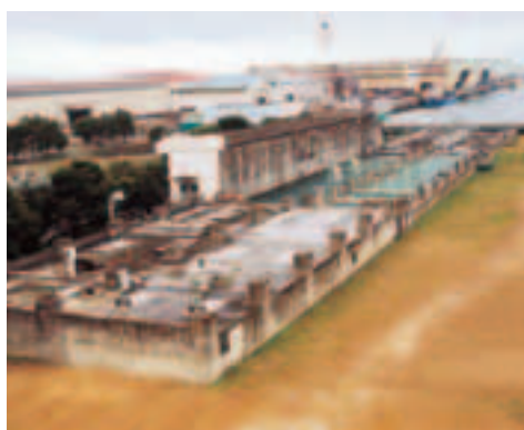
▲ 水処理施設全景
