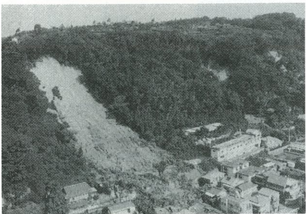
鹿児島で起きたがけ崩れ（昭和61年7月）
