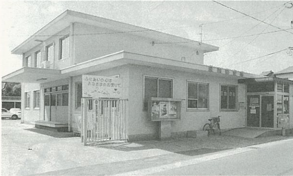
▼解体後の跡地(現在、長洲郵便局)
