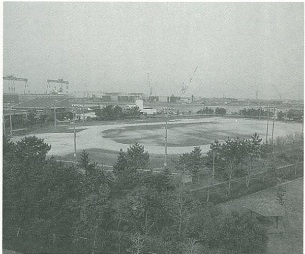
◀整備された総合スポーツセンター
