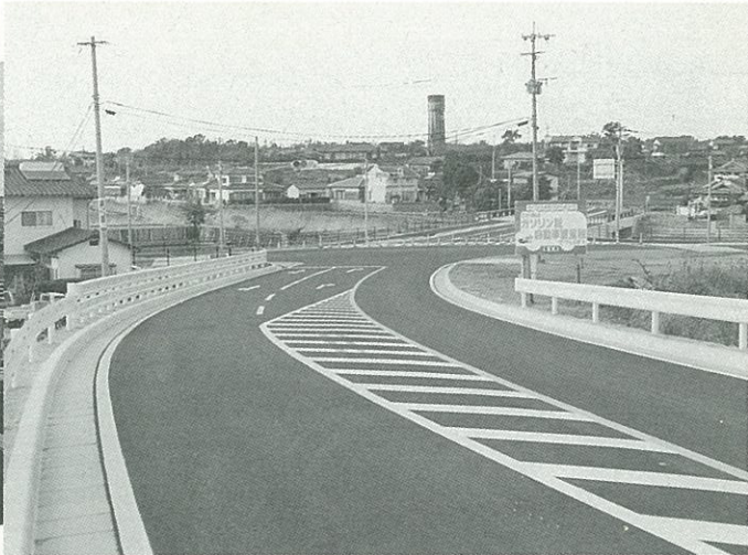
◀整備の進む大谷長洲港線
