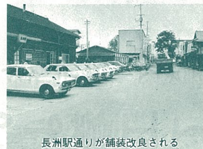
長洲駅通りが舗装改良される
