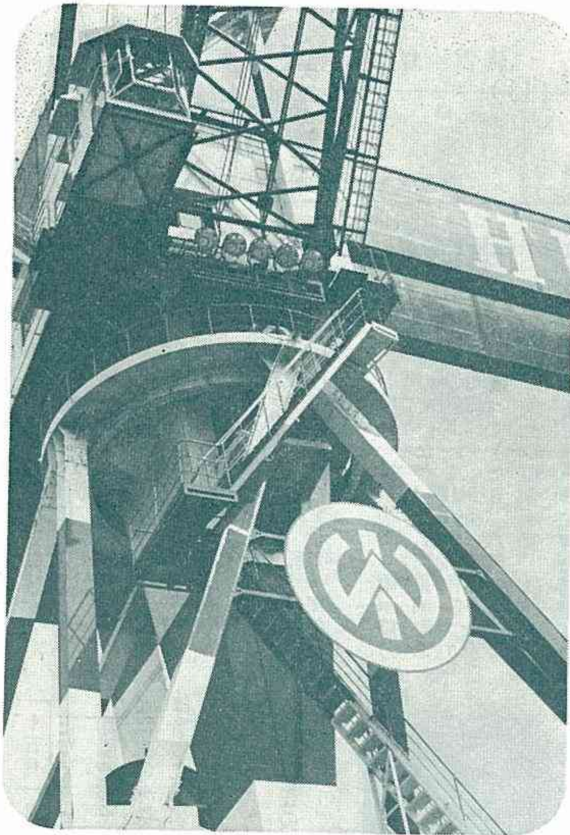
世界最大級の700t ガントリークレーン (航送船を軽くつり上げる能力を持つ)
