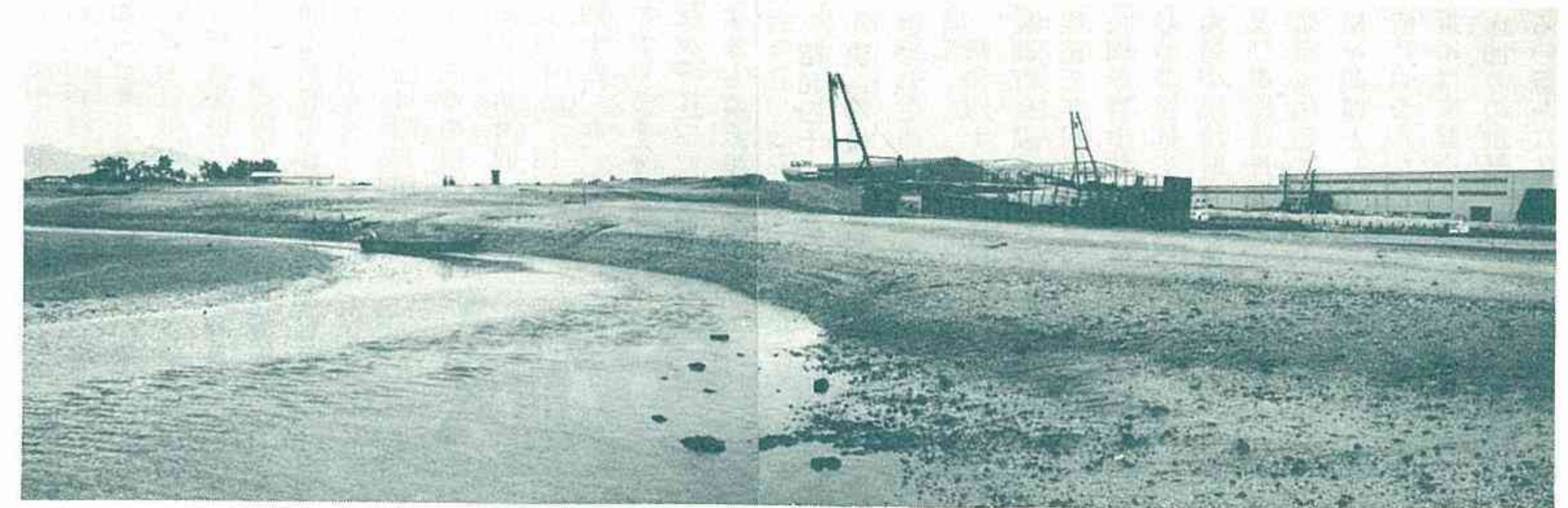
(総合レクリエーション施設及び終末処理場用地造成工事)
