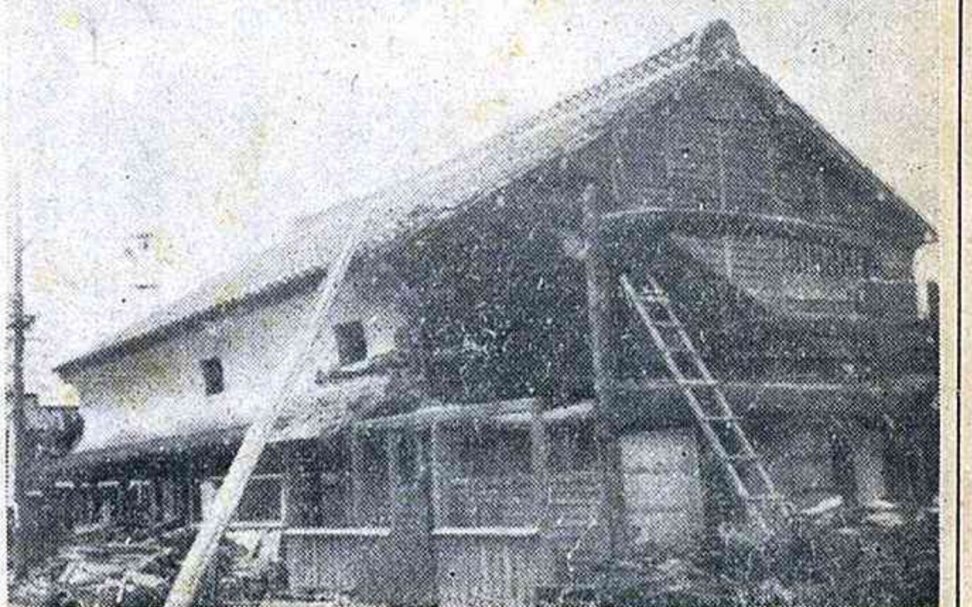
解体すすむ公民館
