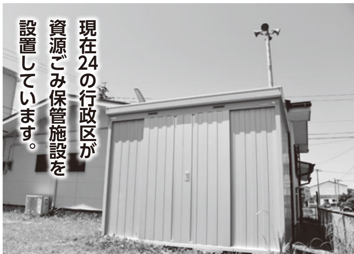
（写真は新山区の保管施設）
