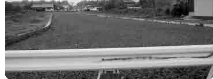
工事途中の幹線道路（荒尾市内）
