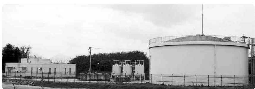
右から貯水槽・ろか機・機械室
