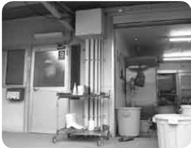
老朽化が進む給食センター
