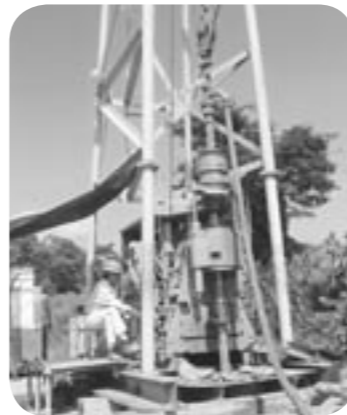
地下水を求めてボーリング
