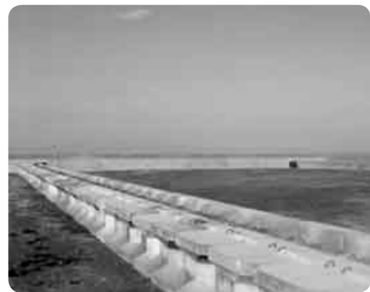
漁業事務所建設が予定されている埋立地
