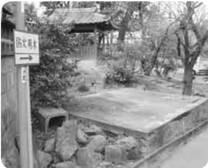
赤崎区にある防火水槽
