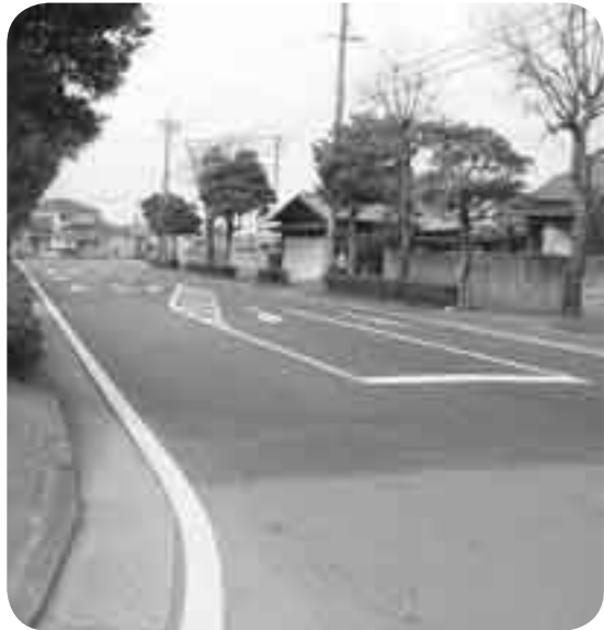
町道の補修箇所 (長洲・岱明線)
