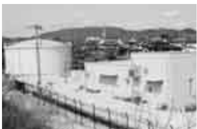
新設した高田浄水場
