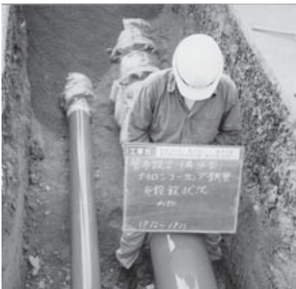
上水道管布設工事
