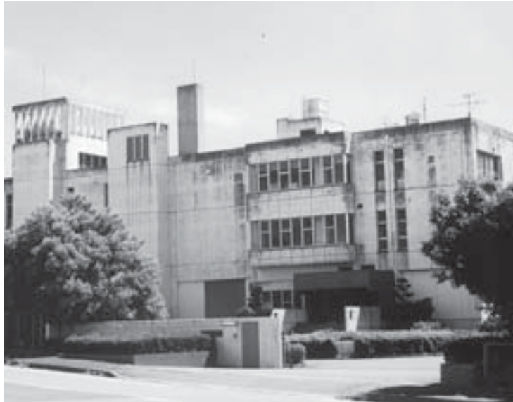
姫ヶ浦の浄化センター
