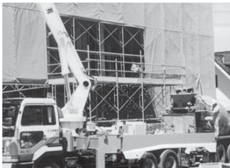
着々と進む工事現場
