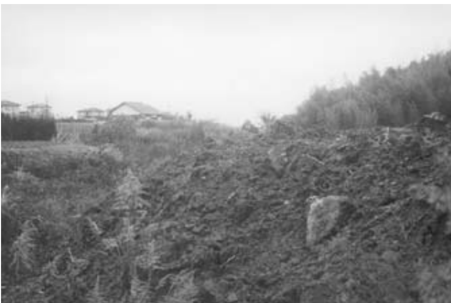
建設予定地の盛土
