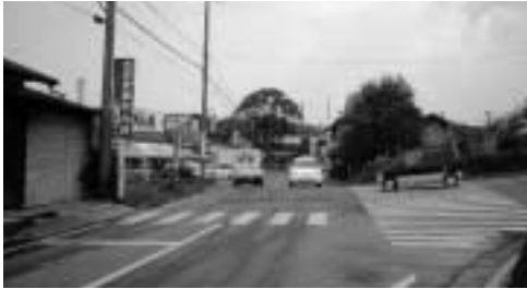
信号機設置待ちのT字路
