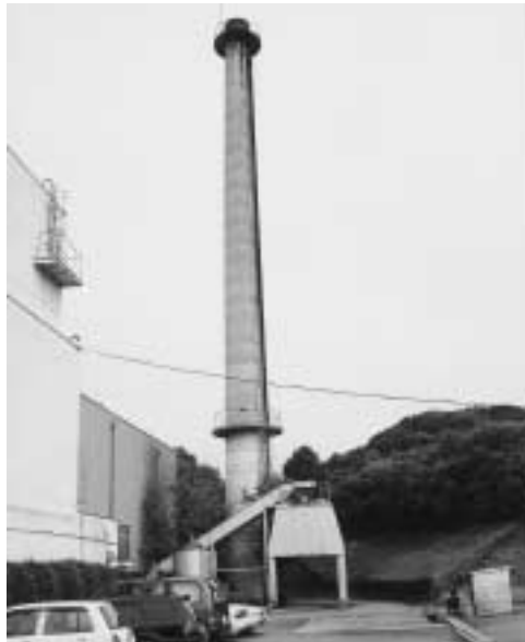
老朽化がはげしい現在の施設
