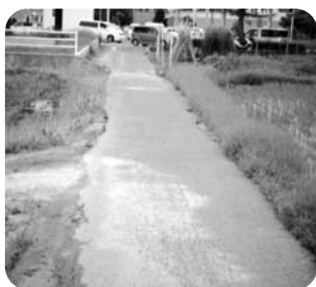
緊急自動車も通れない道
