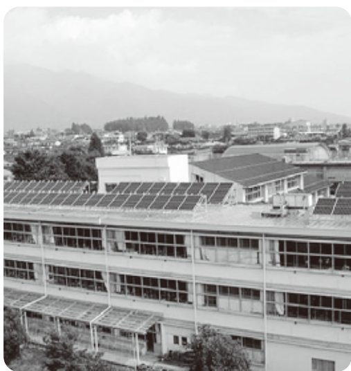
太陽光発電の公共施設設置例 (長野県駒ヶ根市ホームページより抜粋)
