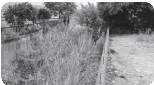
水が流れない東荒神区の水路
