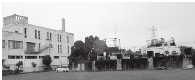
老朽化している長洲町浄化センター
