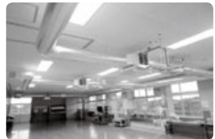
校舎内の換気ダクト工事
