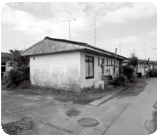
～かなり老朽化が進んでいる平原団地～
