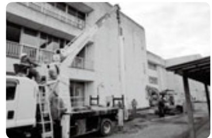
地中熱交換器の埋設工事
