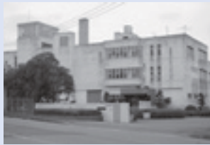
浄化センター 12月29日(土)～1月3日(木)
