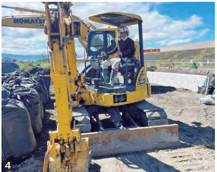
1 社屋外観 2 中島社長 3 現場における作業風景 4 重機を操縦する宮田さん
