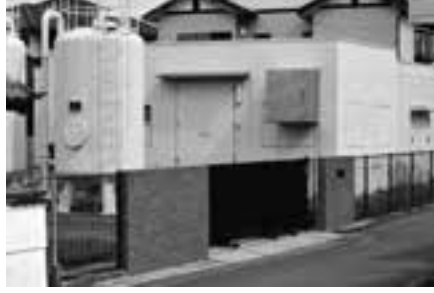
経営健全化のために (梅田浄水場)
