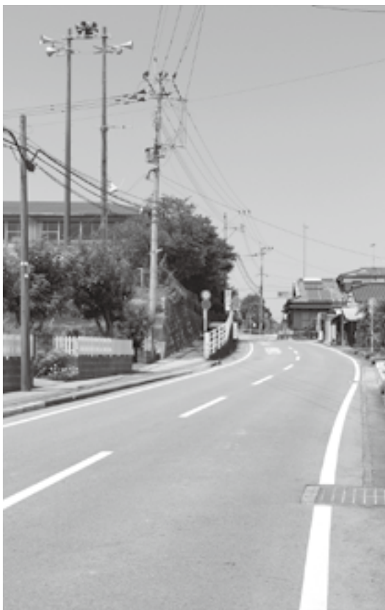
腹赤小学校前の危険箇所
