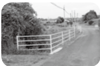
学童を守る転落防止柵を設置
