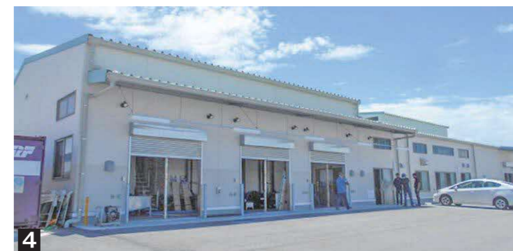
1 社屋・工場外観 2 造船部材の組立溶接作業風景 3 安全作業風景 4 海苔加工場3号棟
