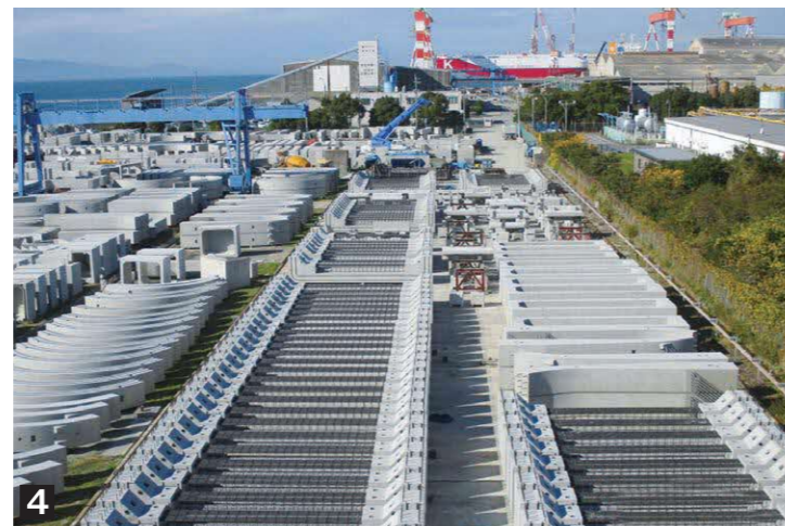
1 工場外観 2 地域未来牽引企業にも選定されました 3 トローリーから流し込まれた生コンクリートを、型枠に流し込んでいきます。 4 出荷を待つコンクリート製品
