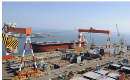
ゴライアスクレーン
