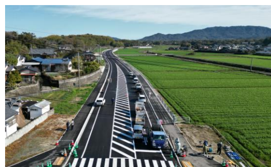
整備が進む都市計画道路赤田上沖洲線
