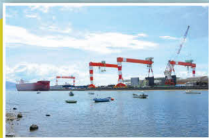
造船所のクレーン
