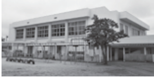
長洲小体育館
