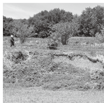
被災した農地復旧工事
