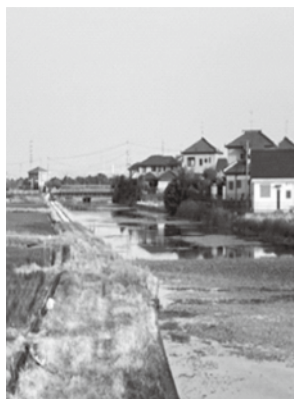
ポンプ頼みの浦川導水路
