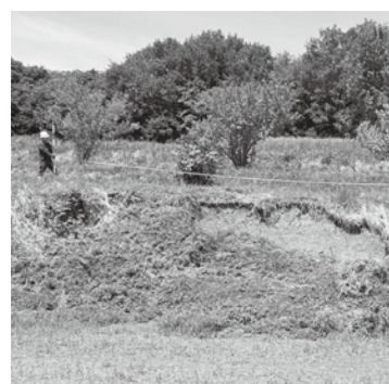
被災した農地復旧工事
