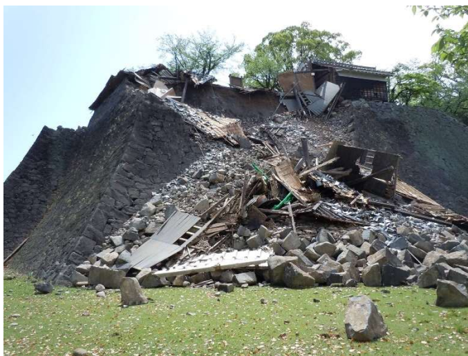
写真 1.1.1 平成 28 年熊本地震による被害 熊本城、北十八間櫓（中央）と東十八間櫓（左奥） 出典：熊本城 Face Book
