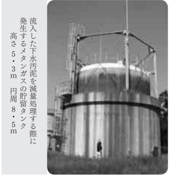
流入した下水汚泥を減量処理する際に発生するメタンガスの貯留タンク
