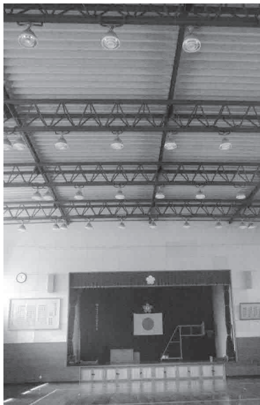
補強される腹赤小体育館天井
