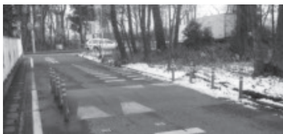
ゆるやかな段差により減速を促す
