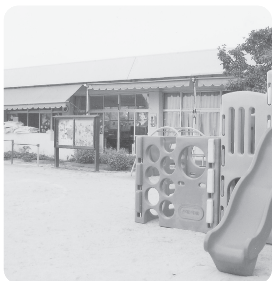
老朽化が進んでいる長洲保育所
