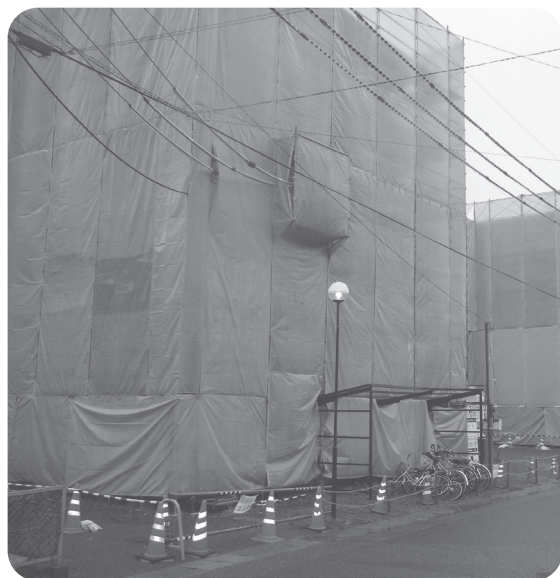
外壁改修工事の行われている新山団地
