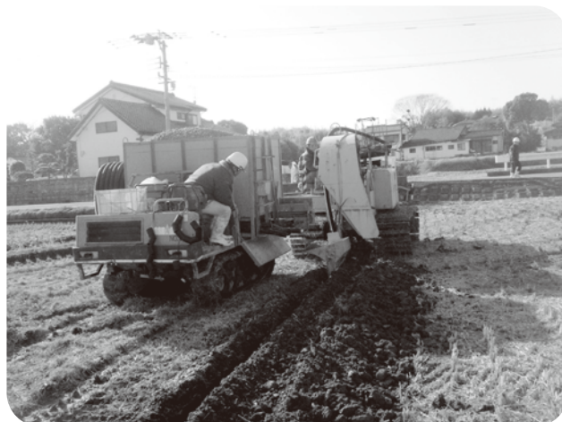
整備が進む暗きょ排水
