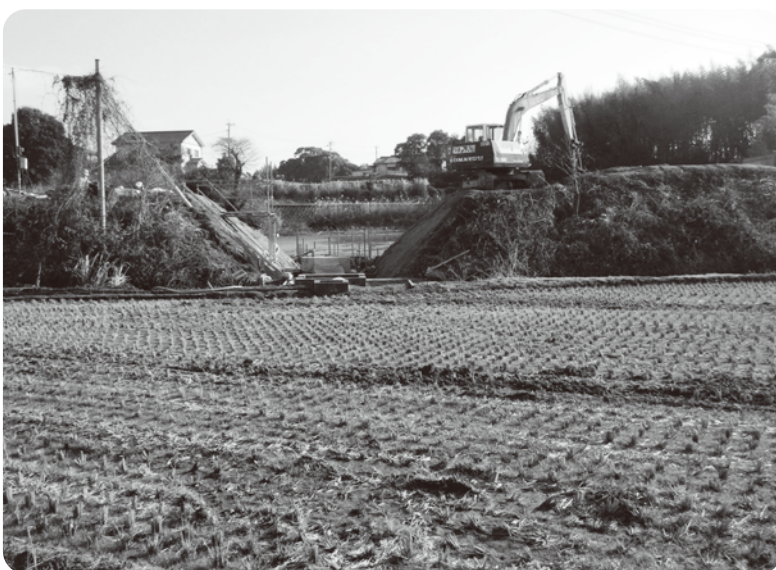
冷水池改修工事
