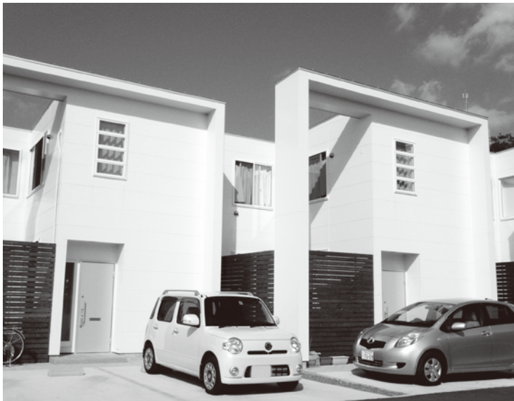
町の施策で作られた賃貸住宅
