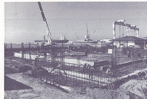
▲来年8月完成予定の屋内温水プール(長洲町民プール)
