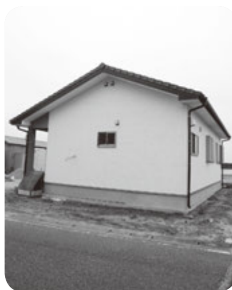
建設中の集会場
