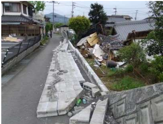
写真 2.1.7 ブロック塀の倒壊
