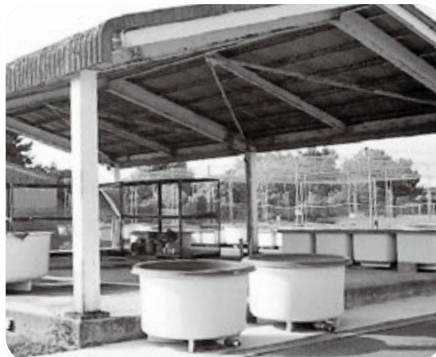
現在の作業場(全景)
